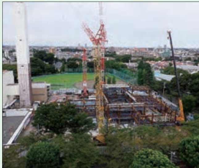
建設中の新武蔵野クリーンセンター（仮称）
