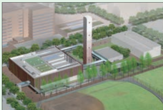
新武蔵野クリーンセンター（仮称）の完成予定図
