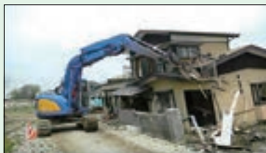
被災家屋を14品目に分別しながら解体
