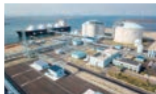
LNG 輸入基地
