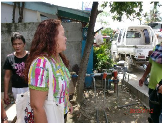
案内してくれたバラングイのリーダー。奥に水道の供給 管が見える。
